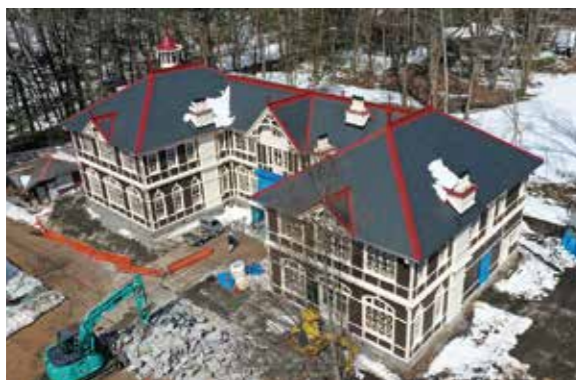
写真提供：清水建設株式会社
