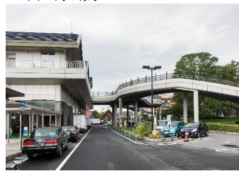
ペDESTリアンデッキの状況
