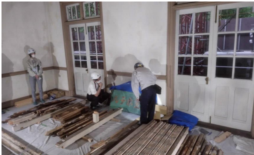
6月25日 文化庁の調査官が現地指導に来町し、室内に保管されている三笠ホテルの看板や解体した玄関庇を見学している様子
