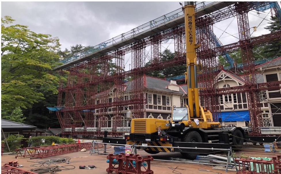
工事のため旧三笠ホテル建物全体を覆う「素屋根」組立の様子
