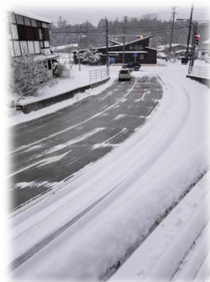
南原陸橋北側 (H31 年設置)
