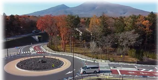
<町道借宿バイパス線（H30 設置）>
