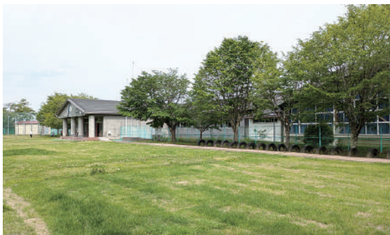
○西部小学校プレハブ仮設校舎跡地
