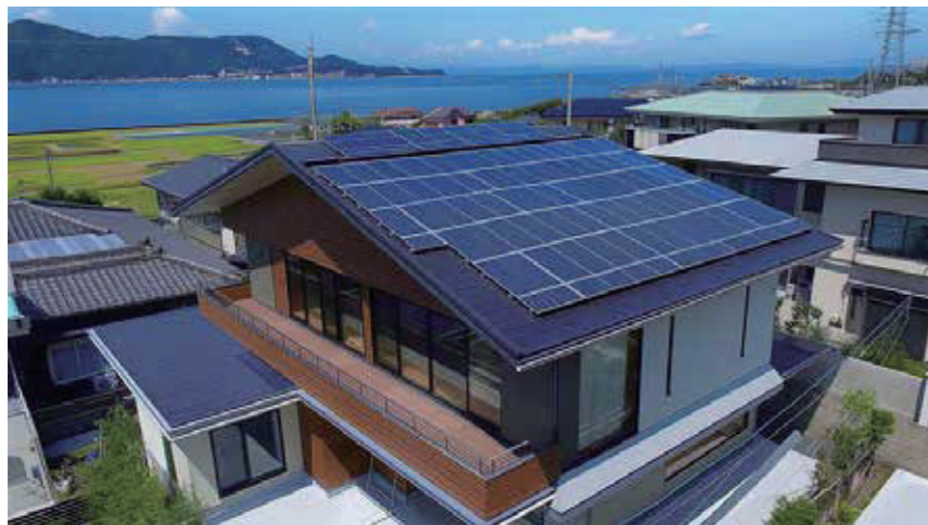
建築モジュールに合わないため無駄が多く、また、美観も悪い
