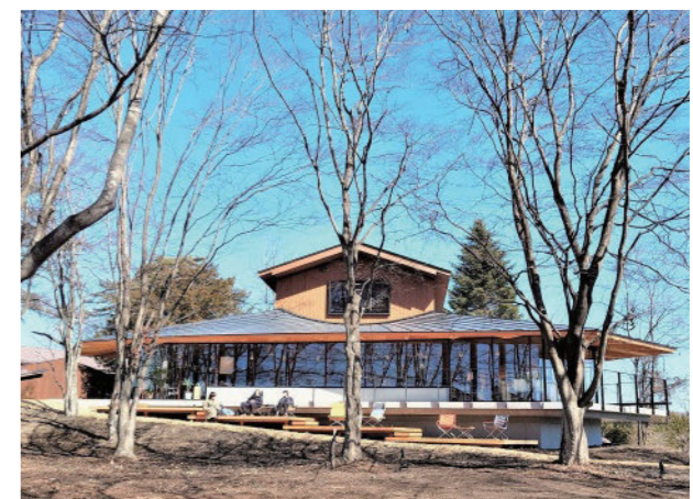
改修後 商業施設
