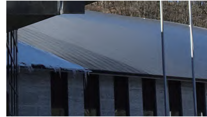
220121撮影（風越公園カーリングホール）：露出した屋根面に日射が当たり、雪が残ってるエリアに熱が伝わることで融雪水を発生させ、氷柱をつくる
