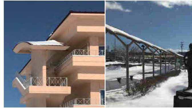
220218撮影（軽井沢病院）：南側のため雪が解けて少なく、また、屋根面の上と下が外気に触れている（温暖差がない）ため、融雪水が少なく氷柱ができにくい
