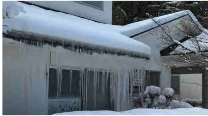
220218撮影（老人福祉センター）：北面のため雪が多く残っており、また、古い建物のため断熱性能が低いことから、氷柱が大きく成長
