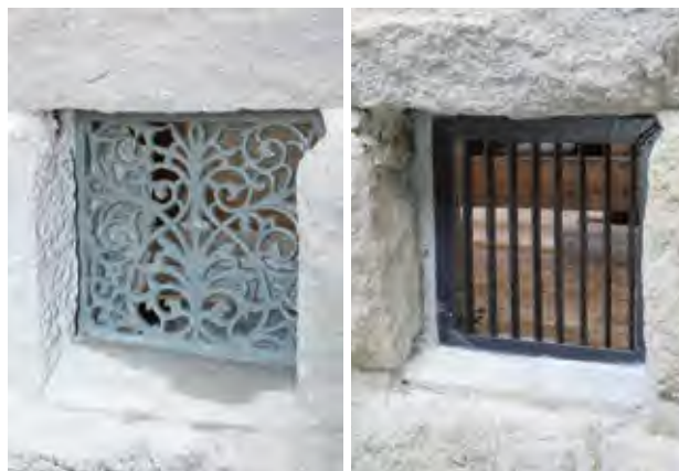
図4-11-3 補修した床下換気口グリル (左：南面中央西寄、右：北面西寄)
