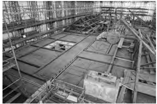
図4-2-1 小屋組の解体完了
