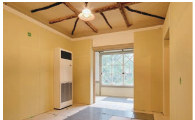
図6-2-3 カフェ厨房の整備完了 (客室No.6)
