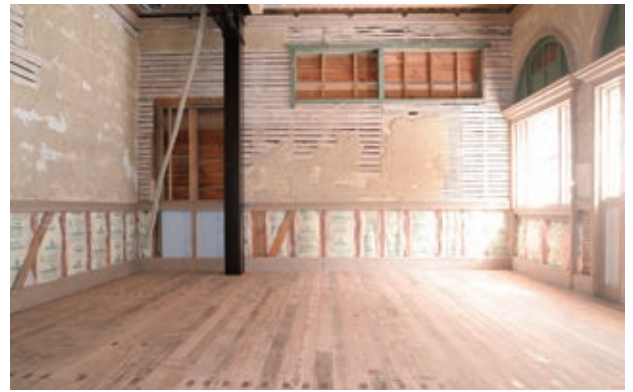
図6-2-2 スタッフ控室の整備前状況 腰下壁に断熱材を充填
