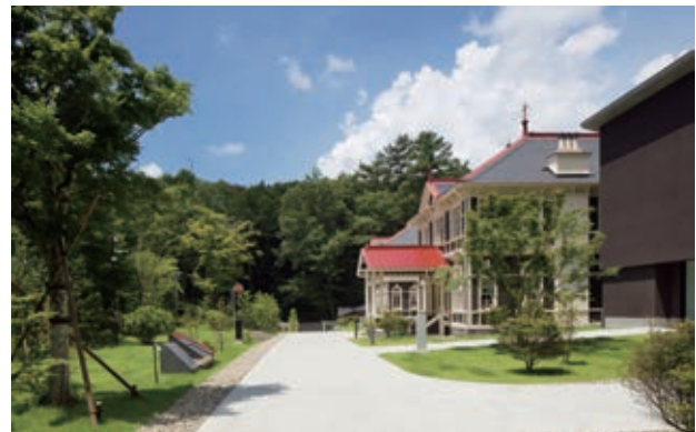
図6-2-10 消火ポンプ室前から敷地入口をみる（竣工）
