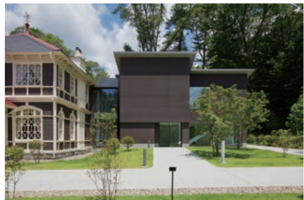
図6-2-5 エレベーター・トイレ棟 南立面（竣工）
