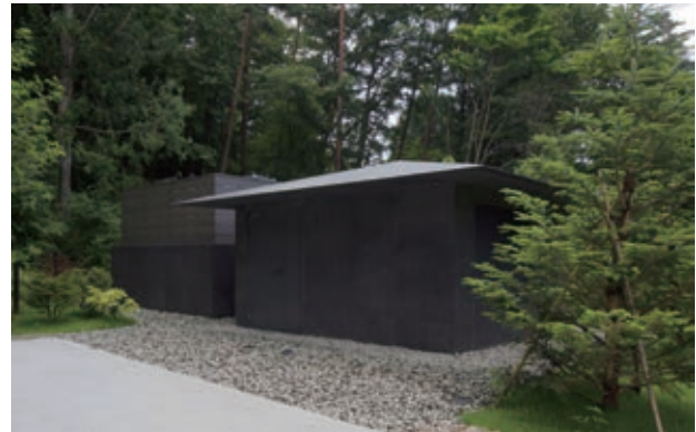
図6-2-9 消火ポンプ室（竣工）
