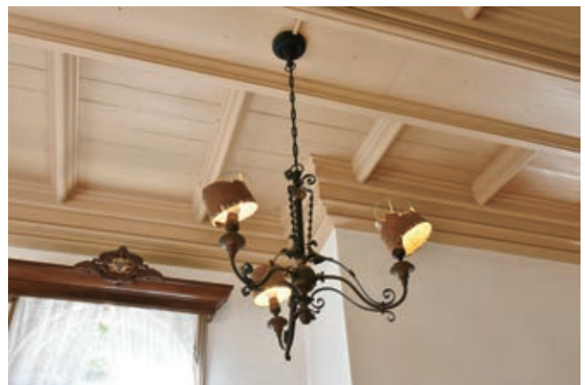
図3-2-8 ロビーシャンデリアのセードの破損（修理前）
