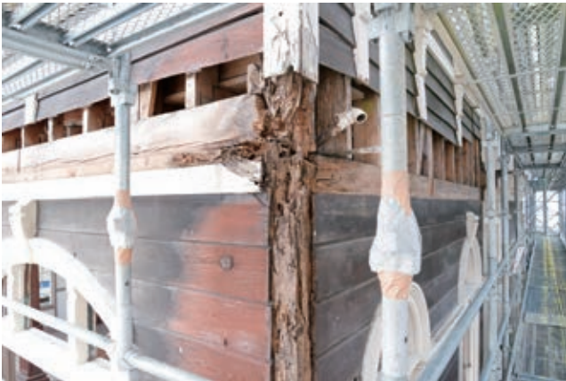
図3-2-2 東翼南東隅柱の腐蝕（付柱・胴蛇腹解体後）
