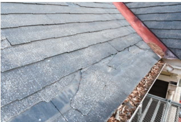
図3-2-4 スレートの割損及び軒樋の閉塞（修理前）
