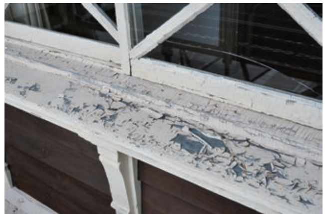
図3-2-7 塗装の剥落及び窓ガラスの割れ（修理前）
