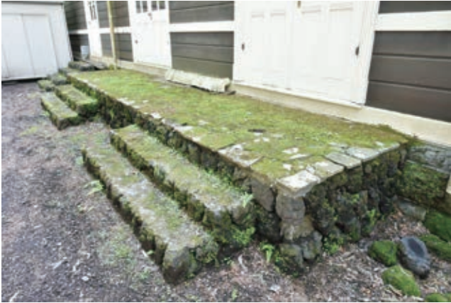
図3-2-1 北側石階段の苔類の繁殖（修理前）
