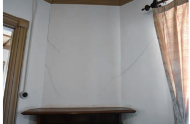
図3-2-5 2階客室No.4の漆喰壁の割れ（修理前）
