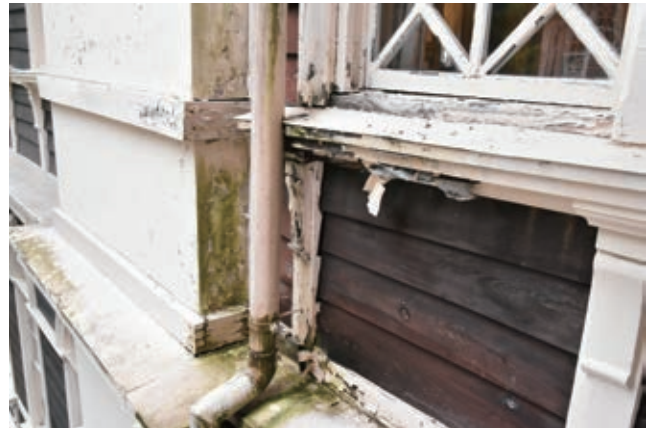
図3-2-6 雨樋周囲の木部や塗装の劣化（修理前）
