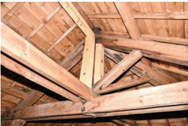
図3-2-3 東翼大棟の雨漏り痕及び応急修理状況（修理前）
