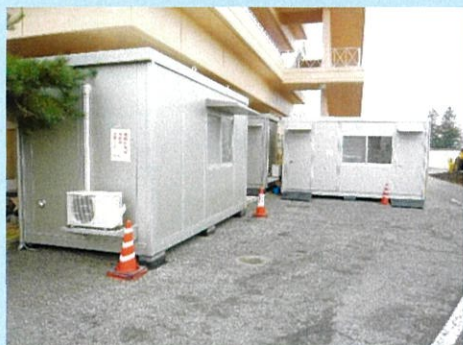
〈屋外に新設されたユニットハウス診察室〉
