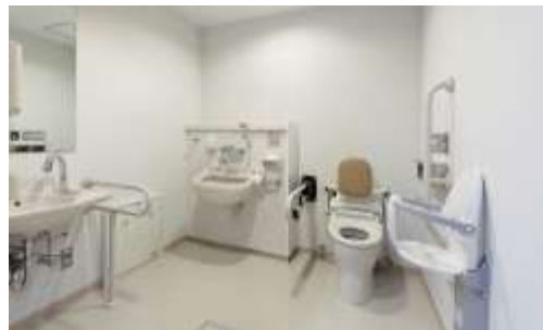
図 4-4-2: 多機能トイレ(立川市庁舎)
