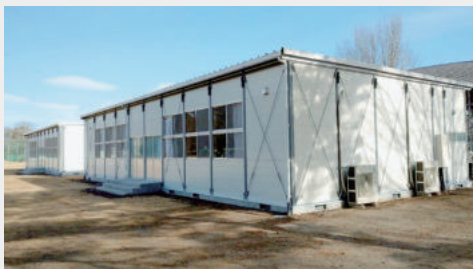
仮設校舎外観
