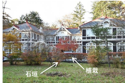
図 3-4. 敷地東西方向に横断する石垣と植栽 (令和保存修理前)
