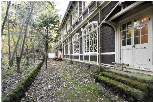
図 3-3. 敷地背面(北側 | 令和保存修理前)
