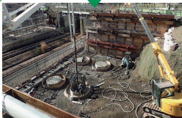
②下部工 基礎工事
