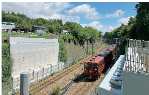
③下部工 橋台完成
