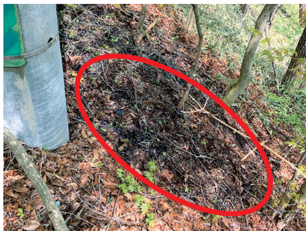
▲カバーが焼損して落下し、落ち葉が焼損
