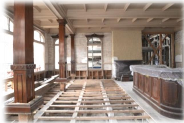
重要文化財・旧三笠ホテル（工事状況）
